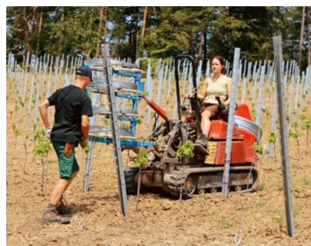
3000 Pfähle, 300 Anker und 110 km Draht: Der grösste Muscaris-Rebberg der Schweiz nimmt Gestalt an. (© Roland Müller)
